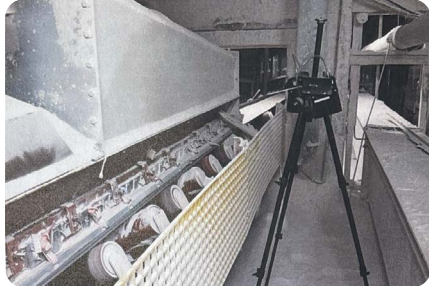
Aufbau der Messinstrumente nach Installation des AirScrape®-Systems.
